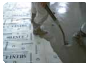
6. getto del massetto di regolarizzazione
