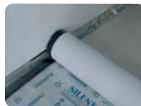
2. srotolamento dei teli
