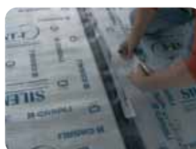
4. stabilizzazione del manto tramite nastratura delle giunzioni.
