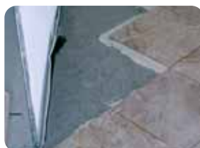
8. posa pavimento finito
